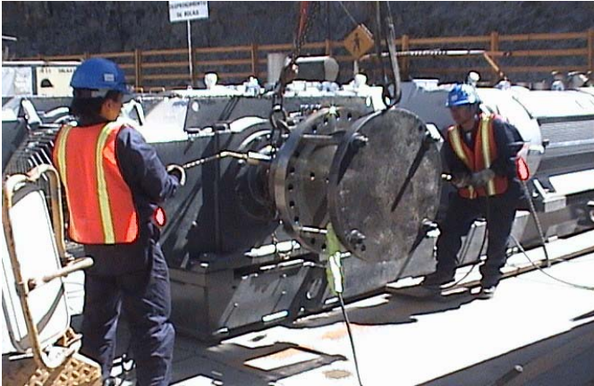
DSC0851.JPG: Extracción del acople
