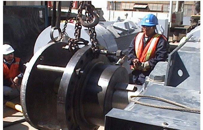
DSC0869.JPG: Extracción del acople
